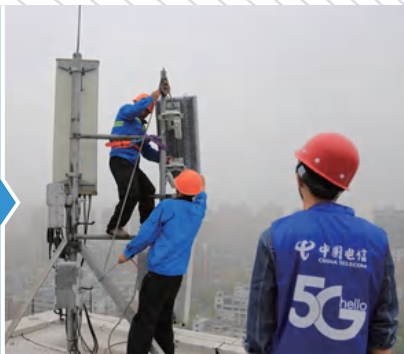
监测与调试 5G通信技术安装、
